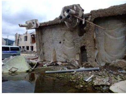
パイルごと抜かれている
