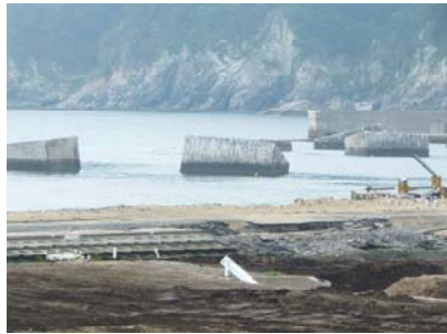
流された防波堤
